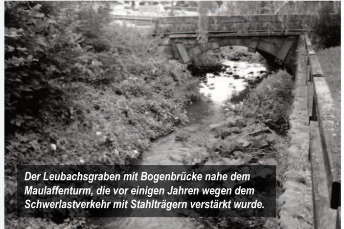
**Der Leubachsgraben mit Bogenbrücke nahe dem Maulaffenturm, die vor einigen Jahren wegen dem Schwerlastverkehr mit Stahlträgern verstärkt wurde.**
